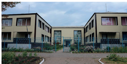
Термомодернізована будівля дитячого садка «Сонечко»
